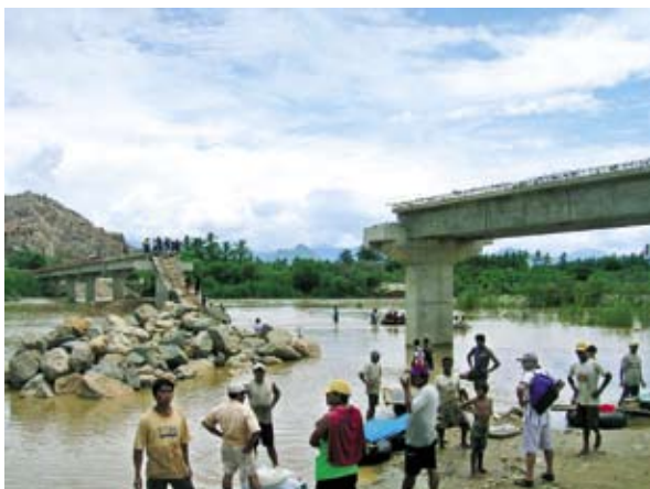
Colapso del puente Viejo Piura en el año 1998
